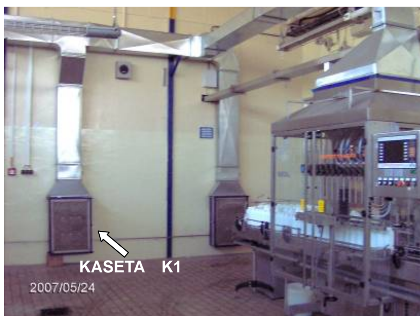
Slika 8. Kasete K1 sa aktivnim ugljem u sistemu ventilacije odeljenja pakovanja
