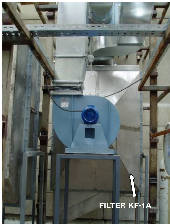
Slika 7. Flilter KF-1A sa 4 kasete K1 za prečišćavanje emisionih gasova odeljenja insekticida
