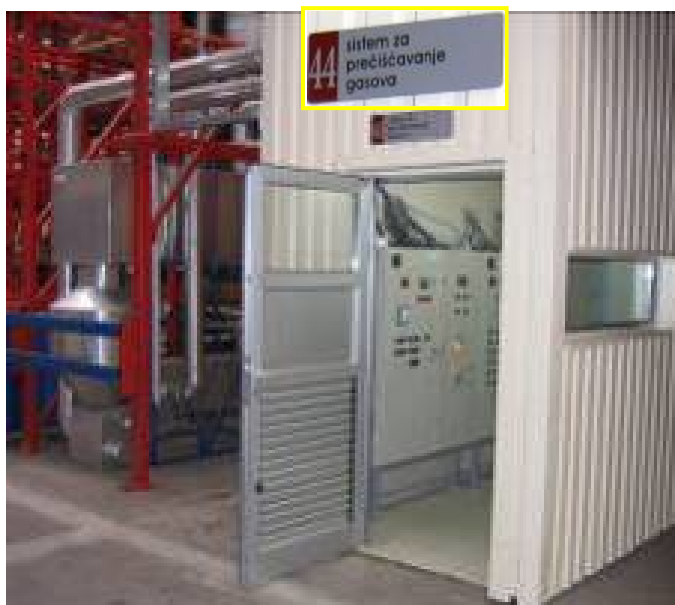
Slika 8. Katalitički reaktor (R-15), rekuperator toplote (REK-24) i komandna soba
