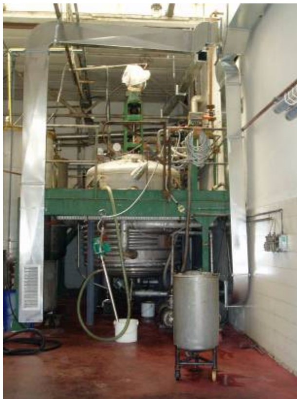
Slika 9. Deo sistema za aspiraciju reaktora za sintezu i opšta ventilacija odeljenja insekticida
